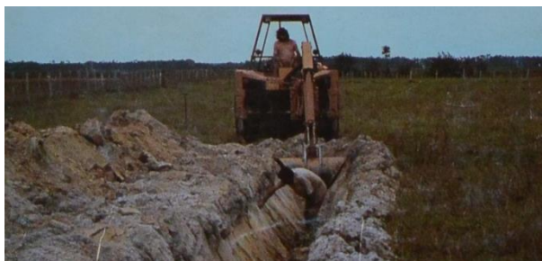
Création de canaux agricoles de drainage à la Pelle – Savanes de Kourou Guyane
