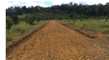
Piste agricole latérite, nivelé et compacté Cacao Guyane.
