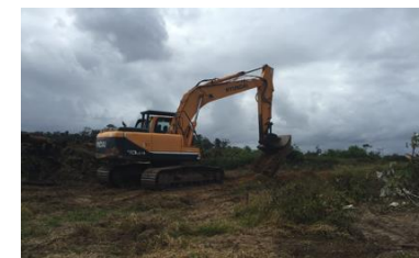
Ouverture des fossés d'écoulements Cacao Guyane.
