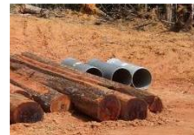
Buses et bois pour la construction de franchissements Bélizon Guyane.
