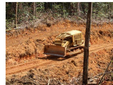
Terrassement d'un profil pente 45% en déblais Bélizon Guyane.
